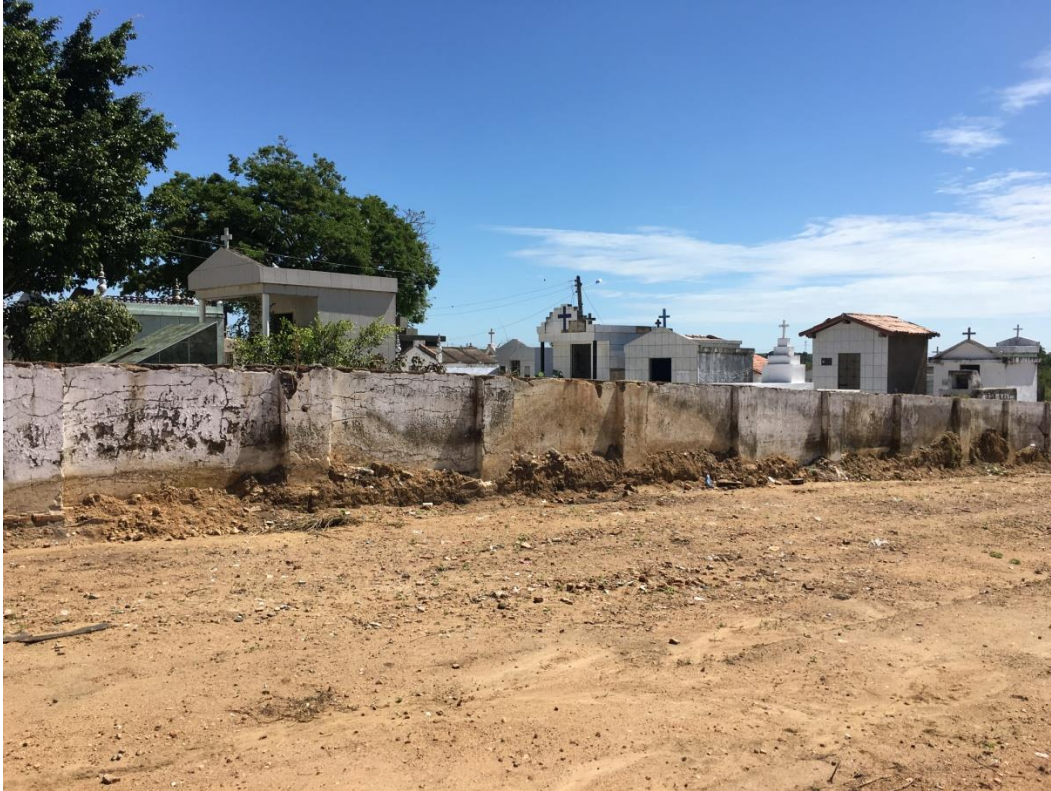
Foto 02 – Muro a ser demolido.
