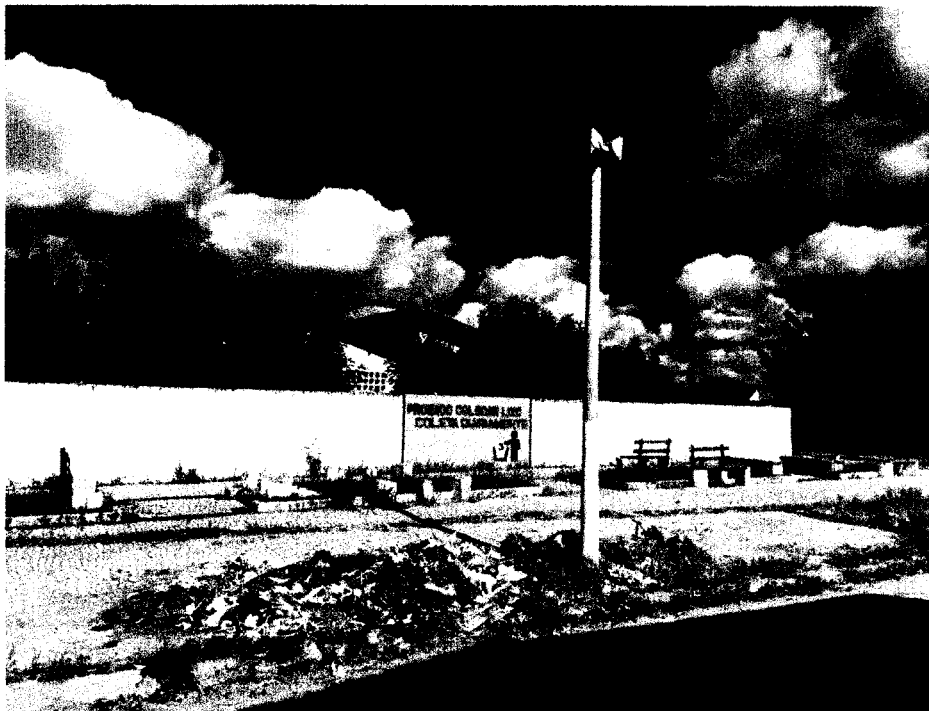
FOTO 08 – MURO EXISTENTE DA ESCOLA QUE SERÁ DEMOLIDO PARA INSTALAÇÃO DE GRADIL, DEIXANDO A REGIÃO DA PRAÇA MAIS ABERTA COM ASPECTO DE SEGURANÇA.
