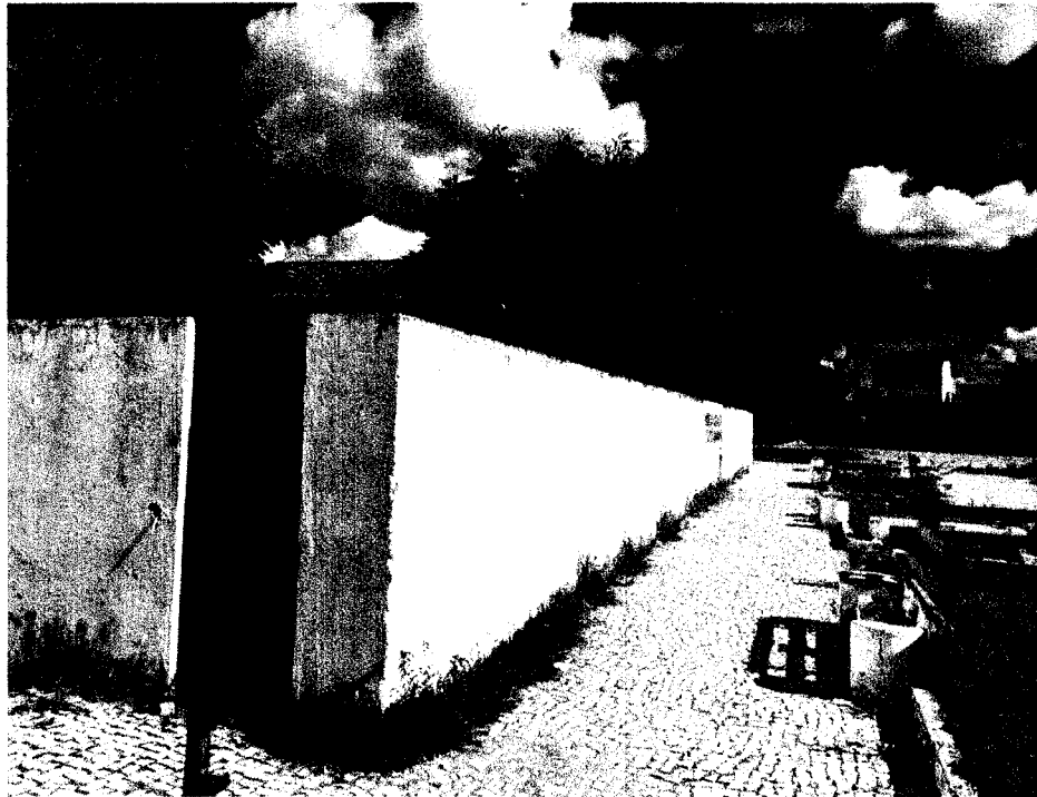
FOTO 07 – NÍVEL DA PRAÇA É MUITO BAIXO EM RELAÇÃO A VIA, OCASIONANDO ALAGAMENTOS EM ÉPOCAS DE CHUVAS.
