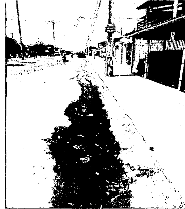
AV: QUINZE DE NOVEMBRO - DRENAGEM EM TUBO PVC 150 MM.
