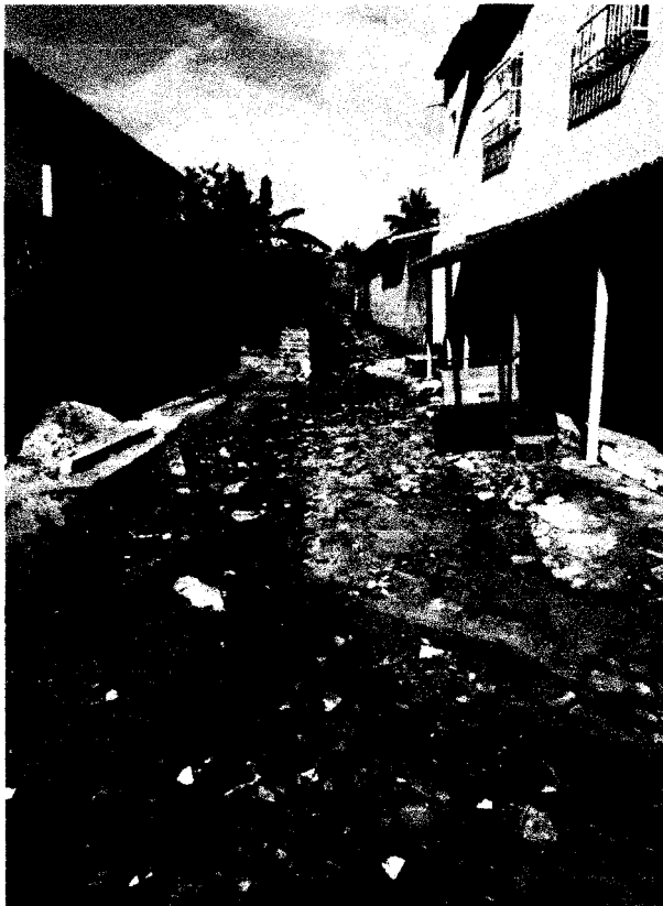
Foto 10 e 11 – Rua Santa Maria e Rua Lameirão – Execução de um sistema de drenagem e execução de pavimentação em pedra Tosca.
