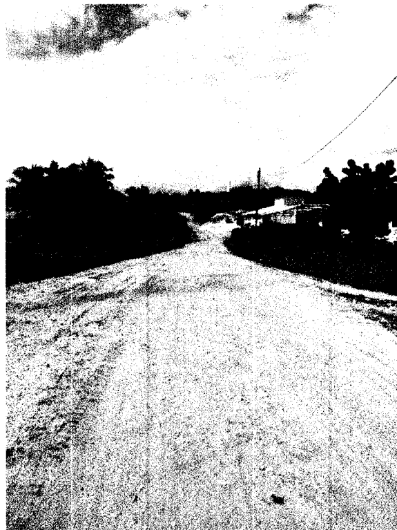
FOTO 5 - RUA S.D.O 1 - TRECHO 03 - FINAL COORDENADAS GEOGRÁFICAS: X: 459930,68 – Y: 9582353,86
